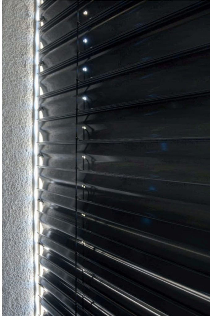
Bild 4. Zulässiger Streulichteinfall über die seitliche Führung
